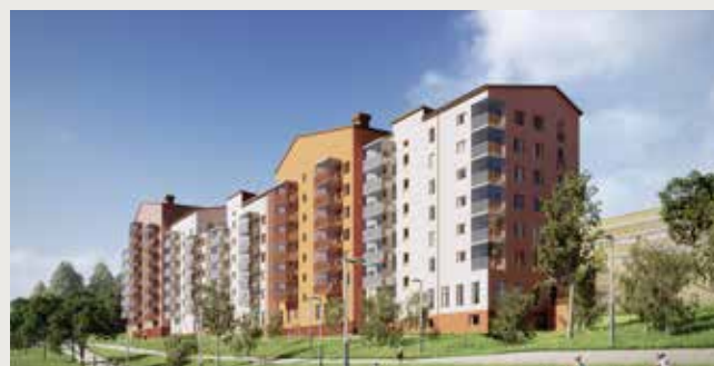
Valla Park, Sundbyberg
