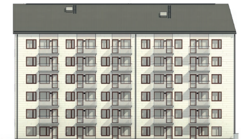
TRAPPHUS 1 MOT VÄSTER
