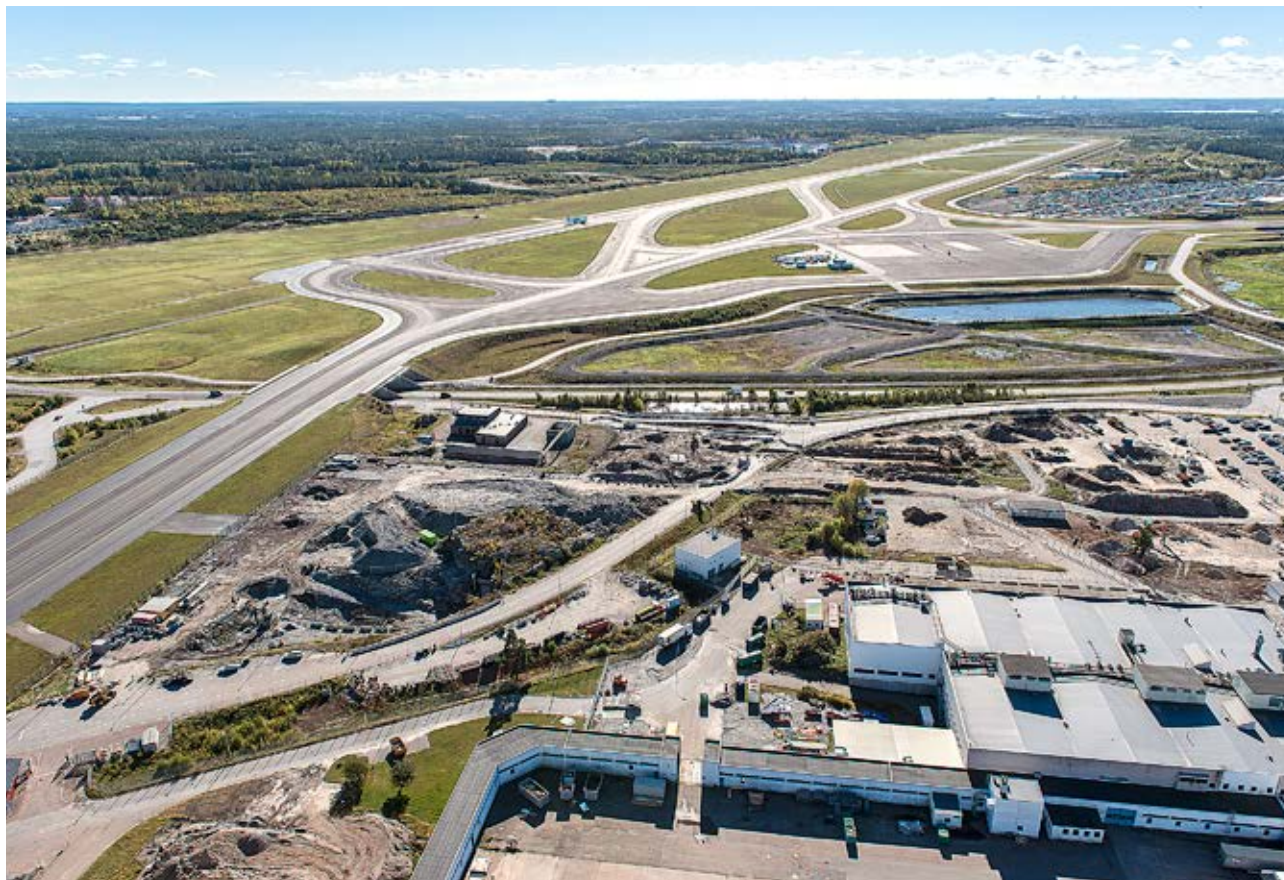
JM Entreprenad bygger nytt driftområde på Arlanda Flygplats.
